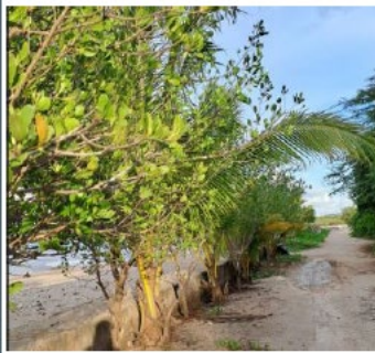
Infrastruktur hybrid pagar tembok dan tanaman hijau sebagai penahan ombak di NTT
